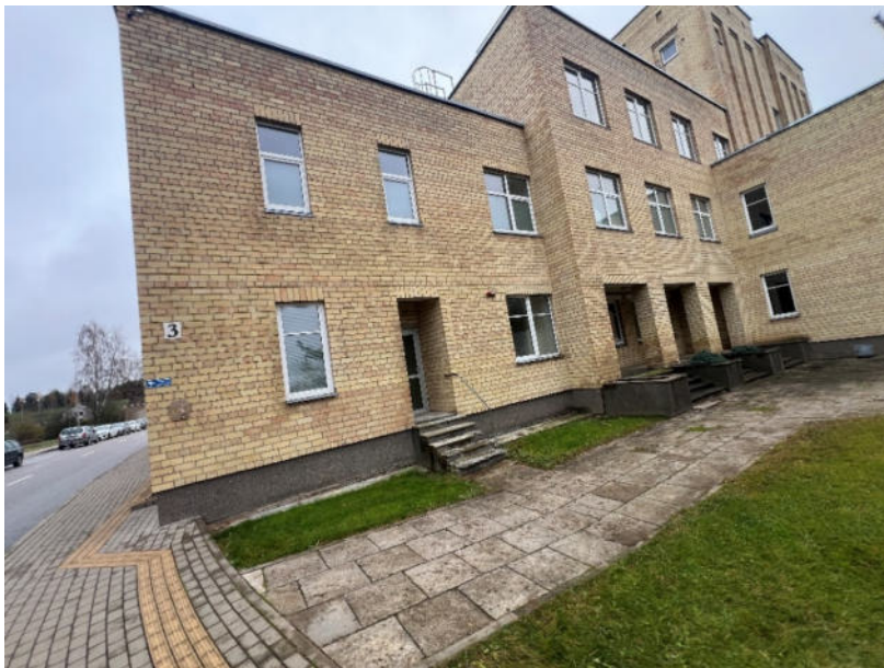
Fotofiksacija pv.2 būklės įvertinimui.
