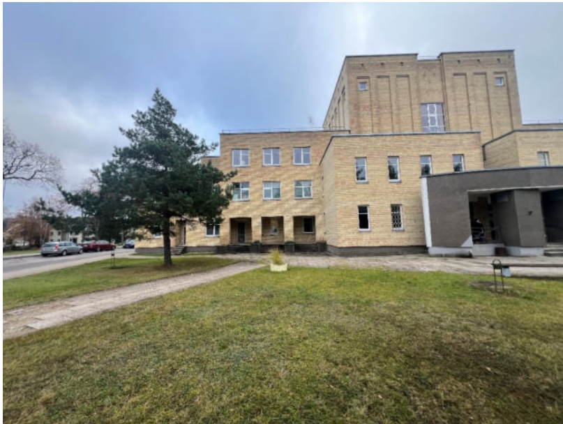
Fotofiksacija pv.1 būklės įvertinimui.
